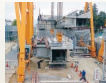
「橋の取壊し」北澤 誠 [滋賀県]
