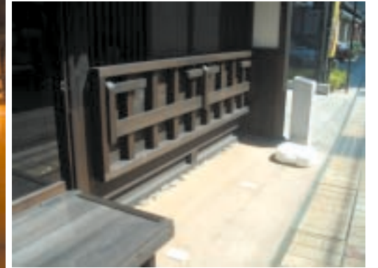
近隣の古い町家を参考にして復原された「ハツリ床几」と「部戸」。
