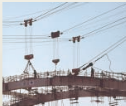
「橋梁の建設」伊藤 武〔長野県〕
