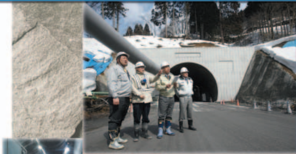
国道365号「椿坂トンネル」
