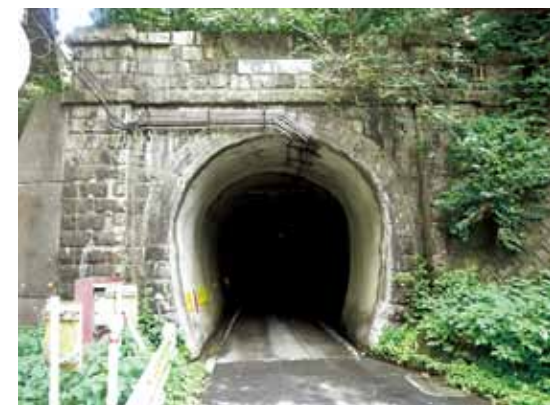
福井県側のトンネル西口
