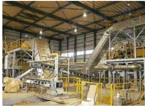
廃木材を選別する前処理設備
