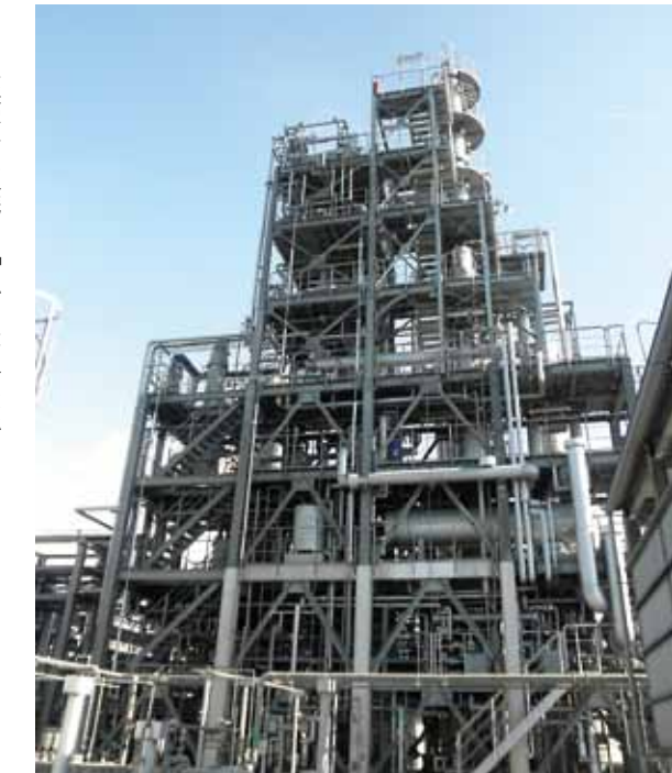
低濃度のエタノールは、濃縮・蒸留・脱水設備でガソリンに添加できる品質に精製される。
