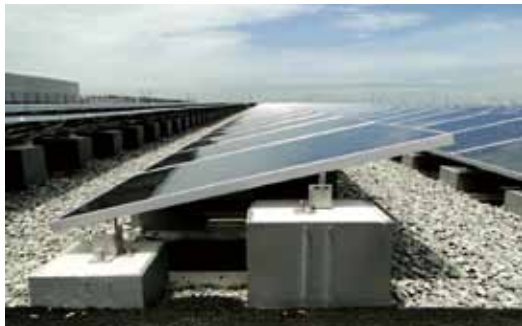
風の影響を考慮して15度というゆるやかな傾斜角でパネルが設置されている
