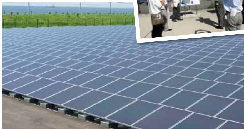
風の影響を考慮して15度というゆるやかな傾斜角でパネルが設置されている
