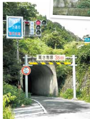
滋賀県側の柳ヶ瀬トンネル東口
