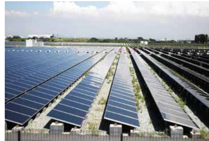
甲子園球場5個分の敷地一面に設置されたソーラーパネル
