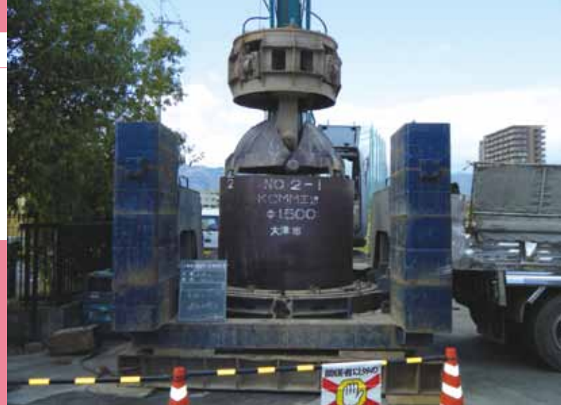
地中に立坑を構築するケコム工法
