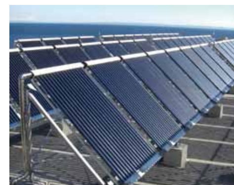
太陽光を利用した給湯・暖房システム
