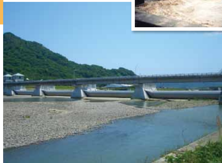
ゴム堰を立ち上げると高さが3.55mになる。
