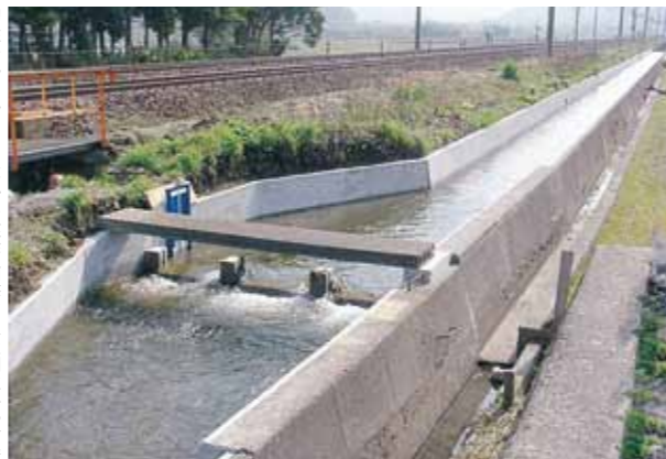
靱性モルタルライニング工法で補修された開水路や石積み水路
