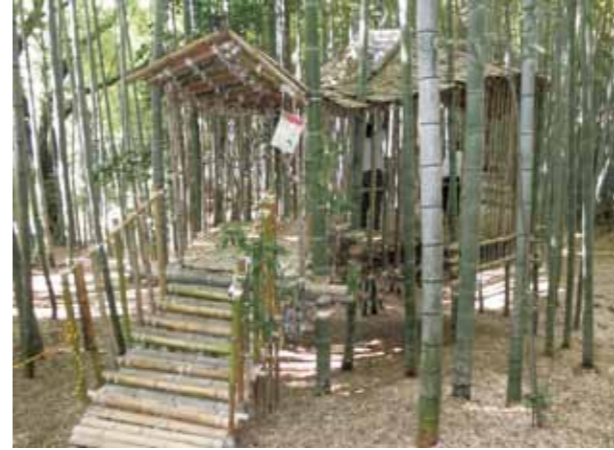
生えている19本の竹を柱にして建てられた高床式のバンブーハウス
