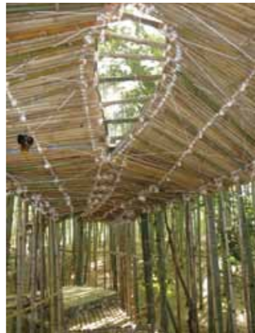
天井にはアクリル板をはめた明かり取りが設けられている。
