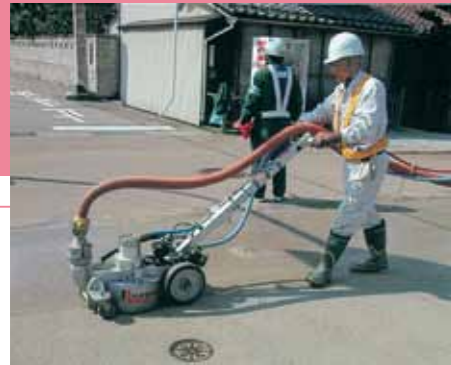
舗装白線の除去や舗装面のすべり抵抗性回復処理などにも活用できるウオータージェット工法
