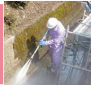
コンクリートの劣化部分を超高压水で取り除くウオータージェット工法
