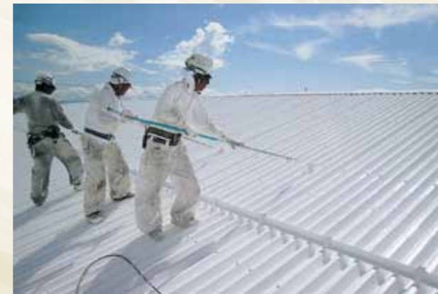
建設業労働災害防止協会滋賀県支部長賞 「塗」 河村 直子〔滋賀県〕
