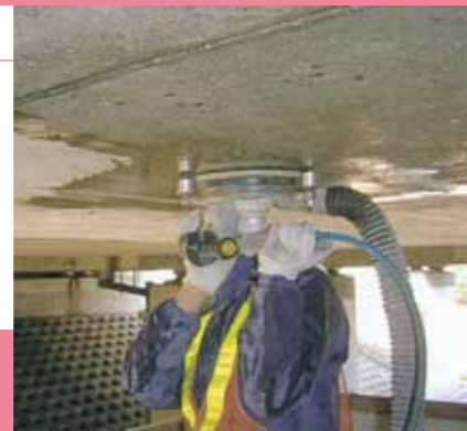
処理水を回収しながら表面除去作業を行うこともできる
