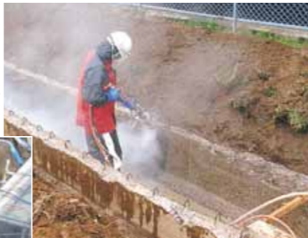
コンクリートの劣化部分を超高压水で取り除くウオータージェット工法
