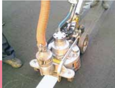
舗装白線の除去や舗装面のすべり抵抗性回復処理などにも活用できるウオータージェット工法
