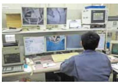
すべての工程は制御室からの遠隔操作で行われている。
