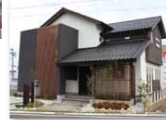
施工例/「環の街」のモデルハウス
