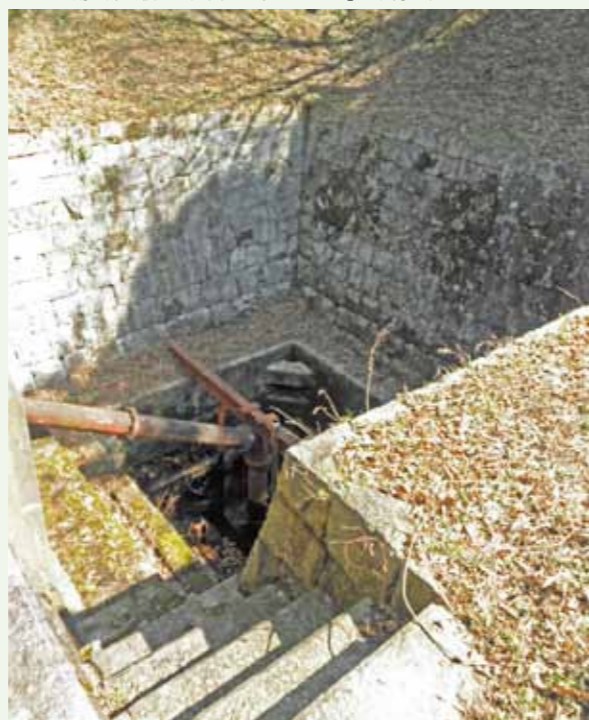
「龍ヶ池揚水機場」 石護岸の揚水池は長さ約16.4m、幅約16.4m（地平面）。 ポイラー用の煉瓦積み煙突には「タツガイ」の文字が見える。
