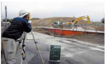
株式会社桑原組 土木部 久米 鴻佑さん 国道161号湖西道路の現場で測量する久米さん。現場では毎日のように新しい発見があるという。
