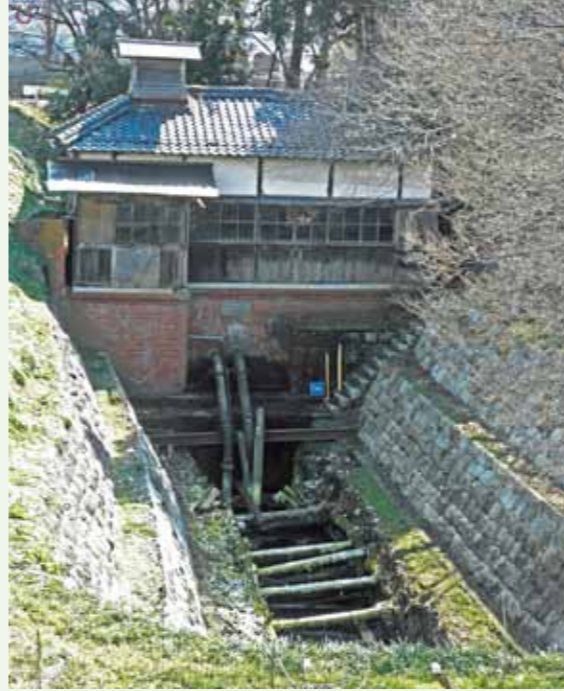
「砂山池揚水機場」 揚水池の大きさは長さ約40m、幅約14.5mと細長い。 ※取材に訪れた時、ちょうど揚水池の改修のための測量が行われていました。作業をされていた方によると「石積みが緩んでいるところがあるので、揚水池に立ち入るのは危険」とのことでした。
