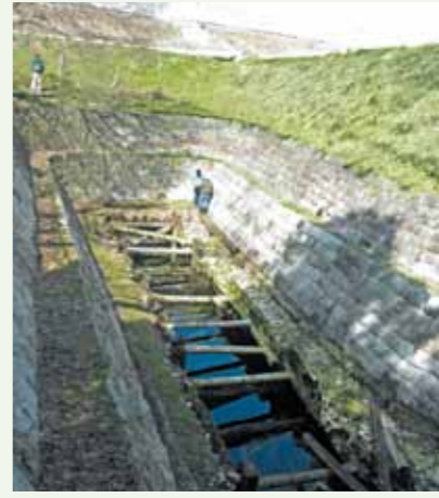
「砂山池揚水機場」 揚水池の大きさは長さ約40m、幅約14.5mと細長い。 ※取材に訪れた時、ちょうど揚水池の改修のための測量が行われていました。作業をされていた方によると「石積みが緩んでいるところがあるので、揚水池に立ち入るのは危険」とのことでした。
