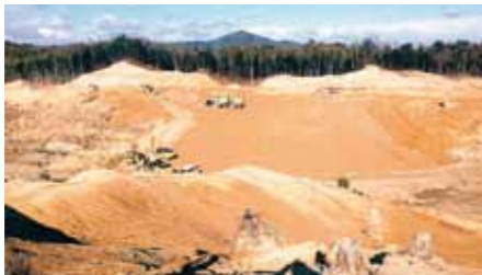
株式会社向茂組 工務部 川添 満さん 現在、川添さんが現場監督見習いとして仕事をしている、電王町の町道岡屋仁殿線の工事現場。
