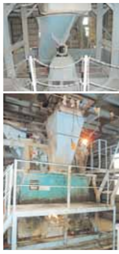
◀計量装置(上)と二軸強制練りミキサー(下) プラントの上部にある計量装置で計量された材料が、下のミキサーに投入され練り混ぜられて生コンができあがる。できあがった生コンはホッパーという装置の下に待ち受けているミキサー車に積み込まれる。
