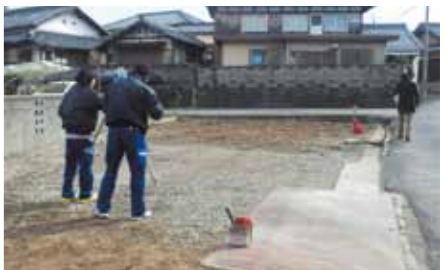
大輪建設株式会社 住宅部 蒲生 真子さん 住宅着工前の測量作業では、これから始まる家づくりに向けて期待と緊張感が高まる。
