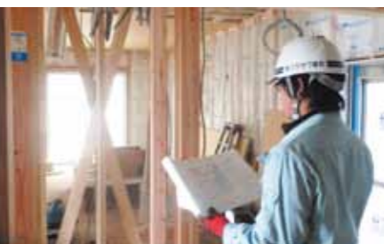
株式会社フジサワ建設 住宅部 石見 拓也さん 建築中の住宅の電気配線を確認。点検業務は長く安全快適に暮らせる家づくりには欠かせない大切な仕事の一つです。
