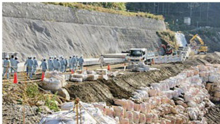
道路拡幅改良の土木工事（谷庄建設）現場を見学する生徒ら
