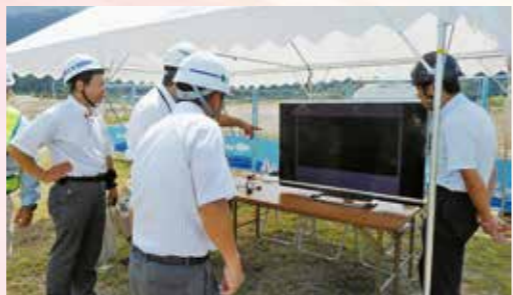
作業中のショベルの動きや、作業後の地面の高さがモニターで確認できる。
