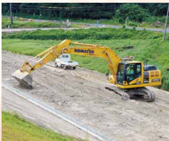
リアルタイムでショベルの位置を確認しながら作業するICT重機(ショベルカー)
