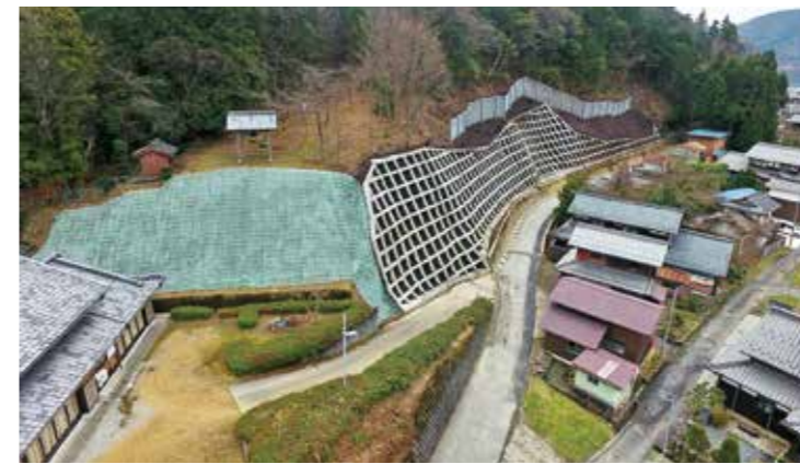
下余呉地区補助急傾斜地崩壊対策工事
