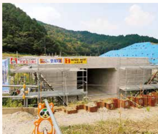
整地された盛土の下を通る水路涵渠が建設されている。
