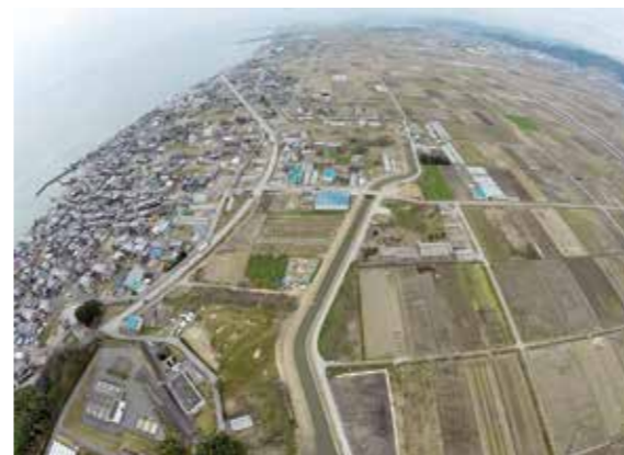
滋賀県優良工事表彰知事賞を受賞した「入江干拓2期地区承水路第1工事」
