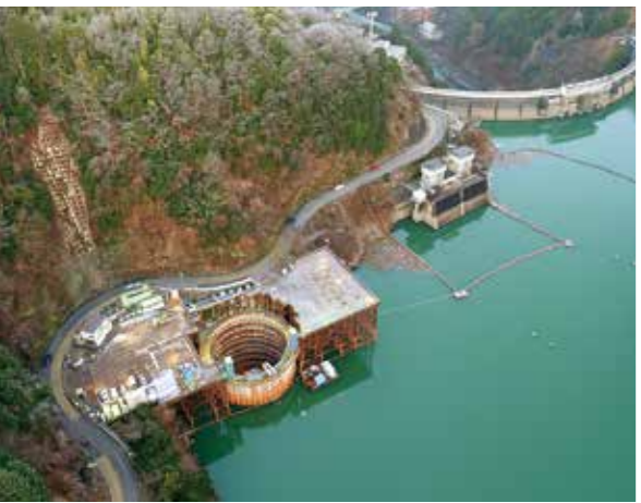
「天ヶ瀬ダム再開発事業 トンネル式放流設備」(京都府宇治市)
