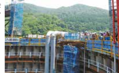
巨大な「トンネル式放流設備」の建設現場を近くで見学することができる。
