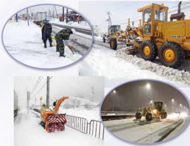
県内には降雪量の多い地域もあり、除雪作業が地域の暮らしを守っている。
