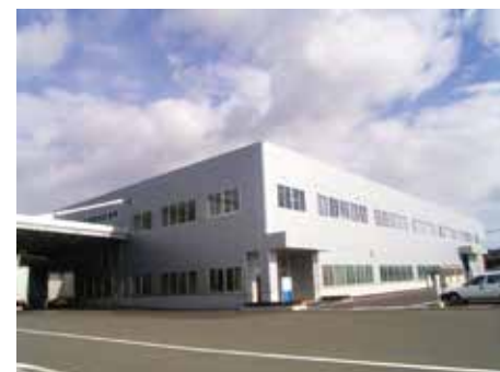
建築施工例 高橋金属株式会社
