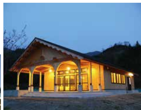
曲谷多目的ホール新築工事
