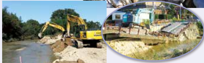
災害復旧に迅速な対応や復旧活動が行えるのも地元建設業の強みだ。
