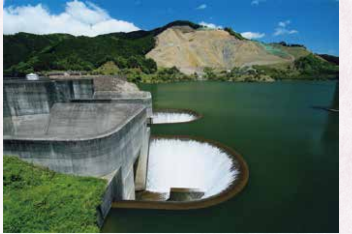
滋賀県建設事業協同組合理事長賞 「豊作への水路」松田 竹史〔滋賀県〕〈滋賀県甲賀市〉
