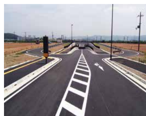
加田田村線(第2工区)緊急地方道路整備工事
