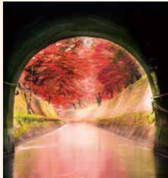
第一トンネル
