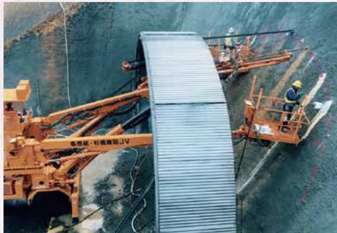
建設業労働災害防止協会滋賀県支部長賞 「フォアポーリング注入中」河原田 剛〔滋賀県〕
