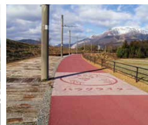
山東・伊吹地区農道集落道路舗装工事
