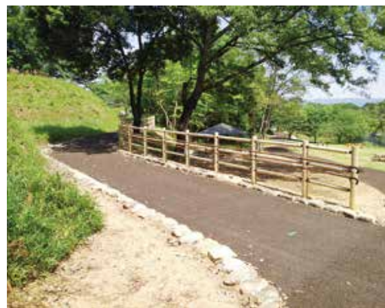
木質加熱アスファルト舗装の施工例
