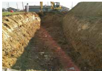
埋設地掘削作業
