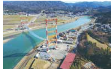
橋を架けるために建設された鉄塔設備
