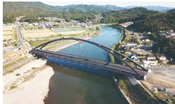
完成した瀬田川令和大橋
