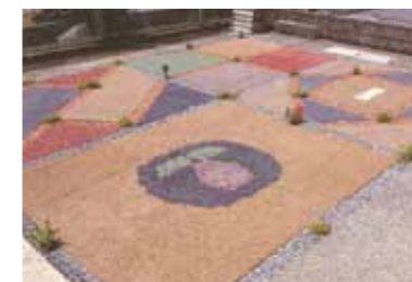
駐車場や歩道、外構などに利用される瓦廃材を再利用した舗装材
