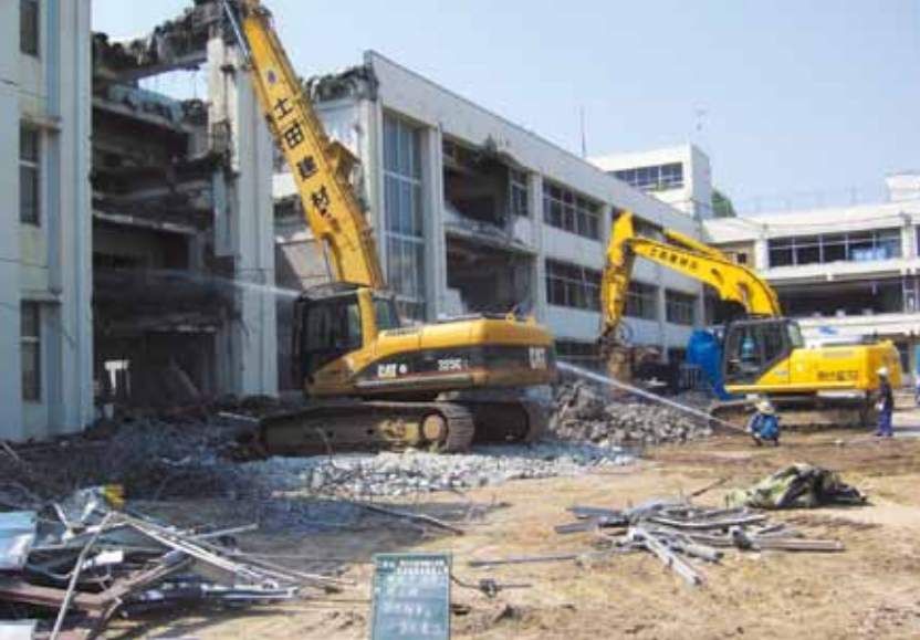
廃材はリサイクルしやすいよう分別しながら解体作業が進められる。
