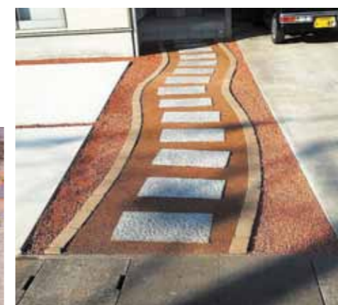
駐車場や歩道、外構などに利用される瓦廃材を再利用した舗装材
