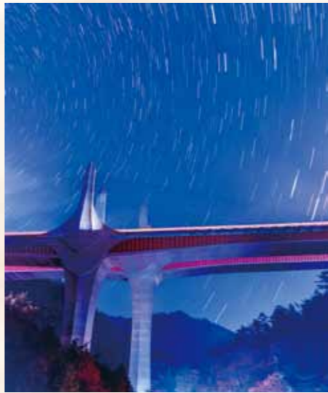
公益社団法人滋賀県建設業団体連合会長賞 「湖南アルプスを跨ぐ」 福田 尚人 [滋賀県] <滋賀県大津市(近江大鳥橋)>
