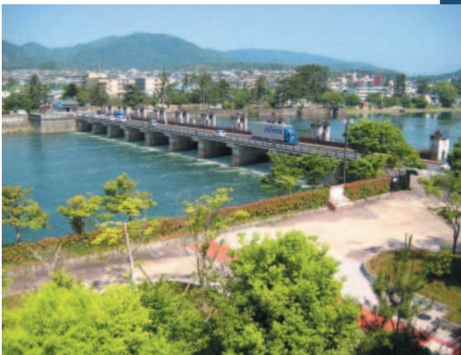
琵琶湖の水の出口で、瀬田川の流量をコントロールする瀬田川洗堰
