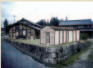
石灰やにがりを混ぜた土を型枠に入れて、たたき締めながら建物を作る工法で、世界中で古くから受け継がれてきた「版築」。「まちなみまるごとアート化活動」の一環として、専門家とまちの人々、参加希望者が一緒になって、信楽に土の家を建てます。
