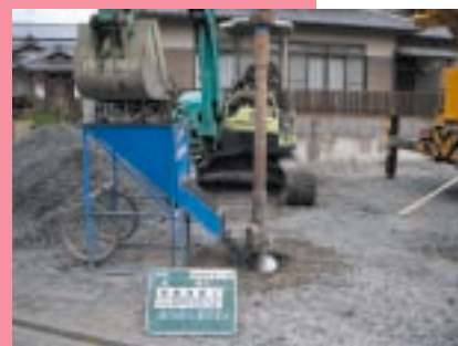
HySpeed工法では、地面の孔に砕石を圧密しながら埋め込んでいく。
