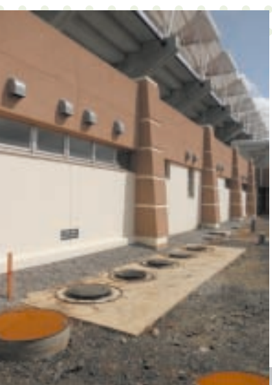
スタンドの1階に設けられた備蓄倉庫。災害時には水のいらぬマンホールトイレになる
