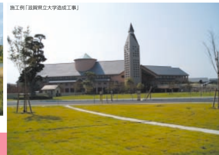
施工例「滋賀県立大学造成工事」
