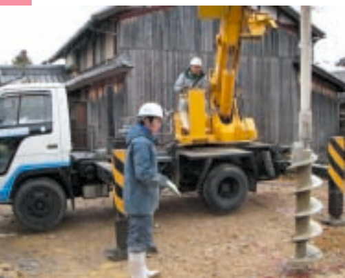
HySpeed工法では、地面の孔に砕石を圧密しながら埋め込んでいく。
