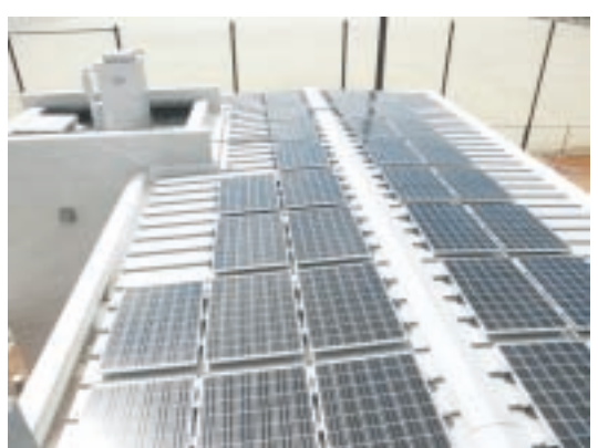
スタンドエントランスの屋根に設置されたソーラーパネル
