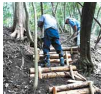
間伐材で階段や橋が整備された金勝山の遊歩道
