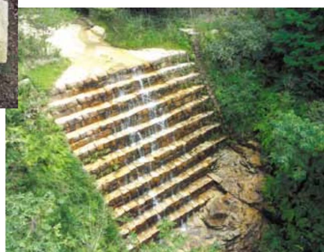
明治22年に建設され、今も現役の鎧塚堤
