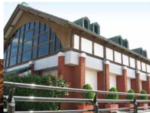
同社が受注して平成12年に完成した長浜鉄道文化館。長さ3メートルの国産杉の5寸丸太をアーチ状に組み上げた木造トラス小屋組工法で建築されている。
