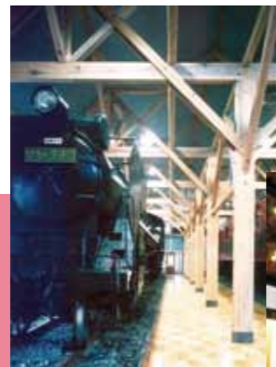
同社が受注して平成12年に完成した長浜鉄道文化館。長さ3メートルの国産杉の5寸丸太をアーチ状に組み上げた木造トラス小屋組工法で建築されている。
