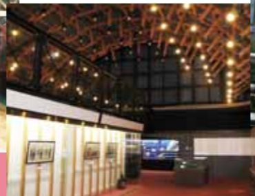
同社が受注して平成12年に完成した長浜鉄道文化館。長さ3メートルの国産杉の5寸丸太をアーチ状に組み上げた木造トラス小屋組工法で建築されている。
