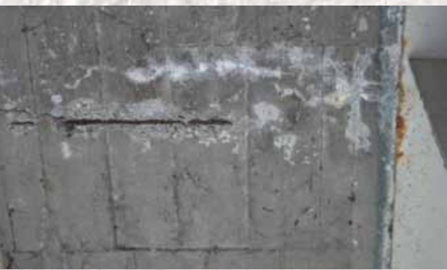
京都市内 地下駐車場 (写真右) 天井の梁に荷重でのひび割れが発生し、そこから鉄筋が腐食した。曲げへの抵抗性がなくなっており、非常に深刻な状況。どちらが先行しているかは判断が難しい。
