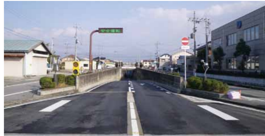
滋賀県発注の祇園八幡中山線道路補修工事
