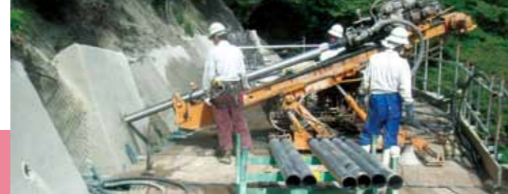
地盤や土質に適合させるグラウンドアンカー工事
