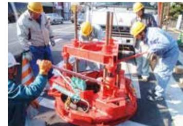
LB工法によるマンホール鉄蓋の撤去作業
