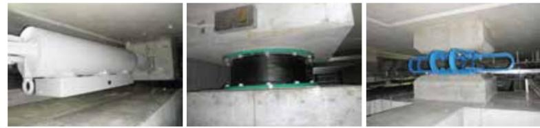
危機管理センターの免震装置 (左から「オイルダンパー」「積層ゴムアイソレーター」「U型鋼材ダンパー」)
