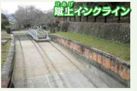
水面の高低差のある蹴上船溜りと南禅寺船溜りを結ぶ延長582メートル、勾配15分の1の傾斜鉄道。船を乗せた台車を引き上げる運転用の巻き上げ機には、蹴上発電所の電力が利用されていました。
