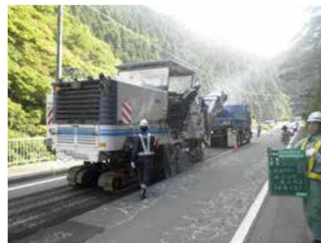
環境に配慮した路盤再生工法（切削オーバーレイ工法）による「国道303号補助道路修繕工事」
