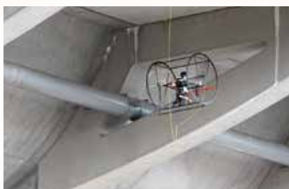
点検ロボットによる狭小なブラケット部の点検
