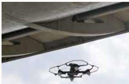
近接撮影ができるドローンによる橋梁の点検
