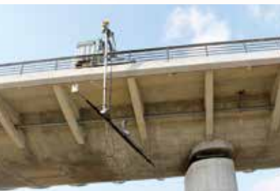
橋梁点検カメラシステムによる支承周りの近接点検
