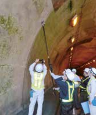
点検や施工実習など実践的な講義が盛り込まれている。
