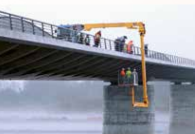
ロボット技術を取り入れた橋梁点検車の性能確認見学会
