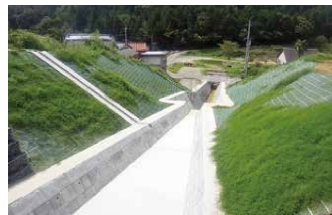
土砂崩壊を防ぐための前川支流砂防工事（日野町）
