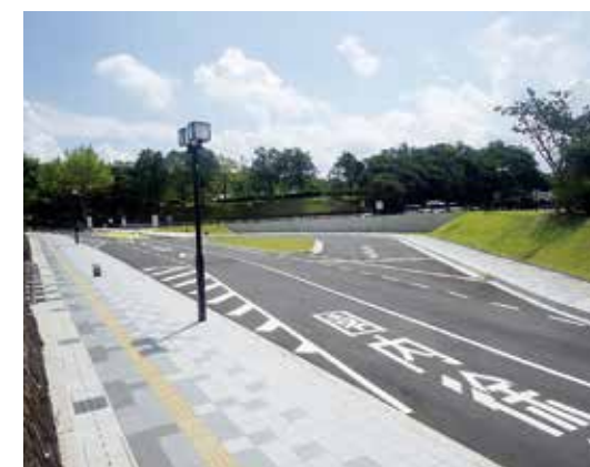
びわこ文化公園の駐車場再整備工事（大津市）
