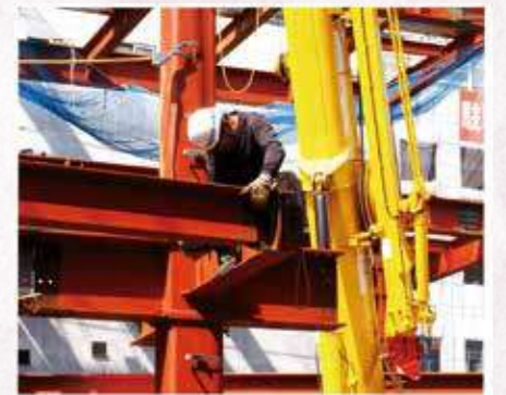
「鉄骨を組み立てる」 中谷 輝雄 [大阪府]
