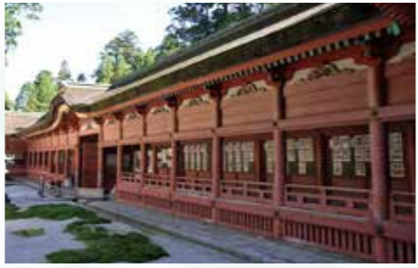
中庭から見た廻廊。頭貫から上が丹塗(たんぬり)、下部は防腐防水効果の高いちゃん塗りになっている。
