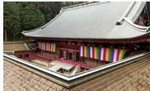
瓦葺のように見えるが、表面を銅板で覆った「瓦葺銅板葺」の大屋根。手前は廻廊のとち葺きの屋根。
