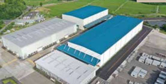
施工例：株式会社メイコン日野第二センター5号倉庫増築工事
