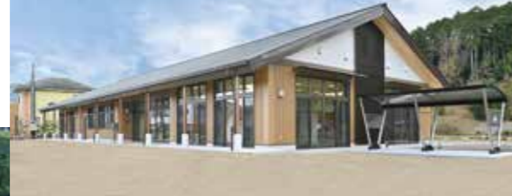
施工例：松籟会館改築工事
