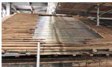
廻廊の屋根。風雨にさらされた軒付きが傷んでいるのが見える。
