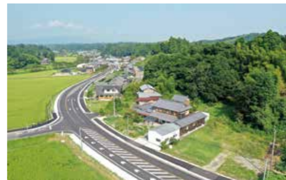
施工例：小佐治甲南線補助道路整備工事（道路）
