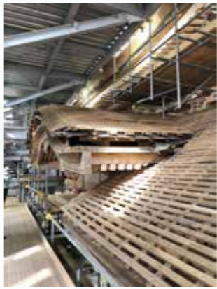
廻廊のとち葺きの屋根と南の車寄せ。下地材だけになっている。
