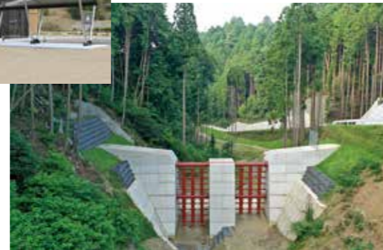
施工例：風呂山谷補助通常砂防工事
