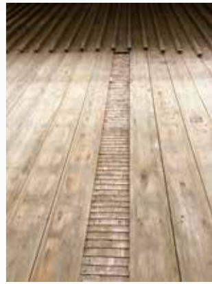
銅板を取り払った本堂の大屋根。下地板の下に土居葺きが見える。
