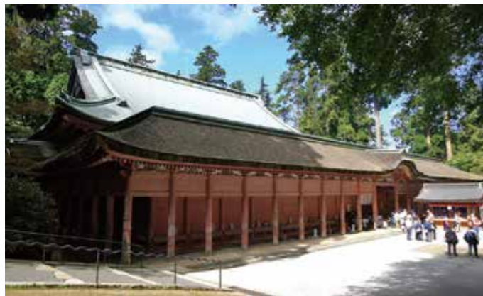
改修工事前の根本中堂外観。塗装などの傷みが見える。
