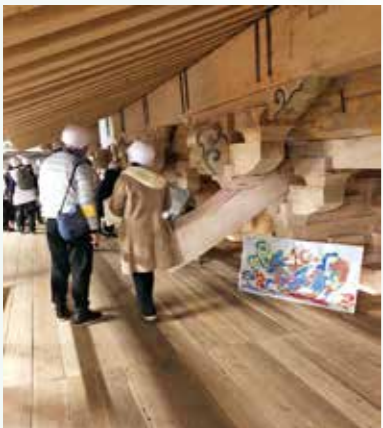
塗装が掻き落とされた組物。
