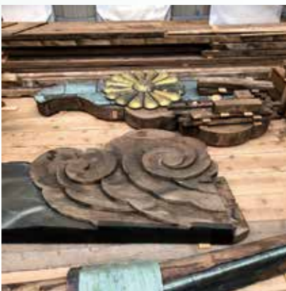
組物や飾り金具、紋金具も丁寧に解体し、調査と補修が行われる。
