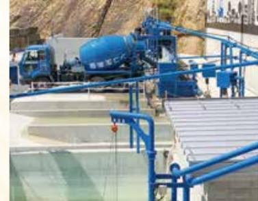
プラントやミキサー車の洗浄水を処理してリサイクルする施設
