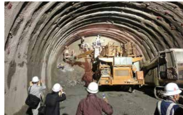
観音坂トンネル（長浜市石田町～米原市朝日）施工の様子
