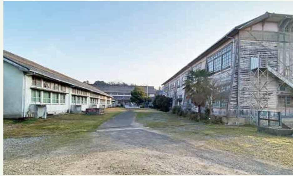
昭和5年に建てられた木造校舎、正面奥は体育館
