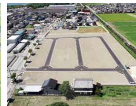
住宅整備工事（長浜市祇園町）
