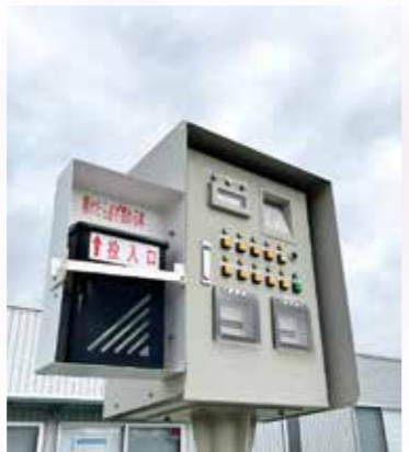
プラントに無人計量器を設置して窓口業務の負担を軽減した。
