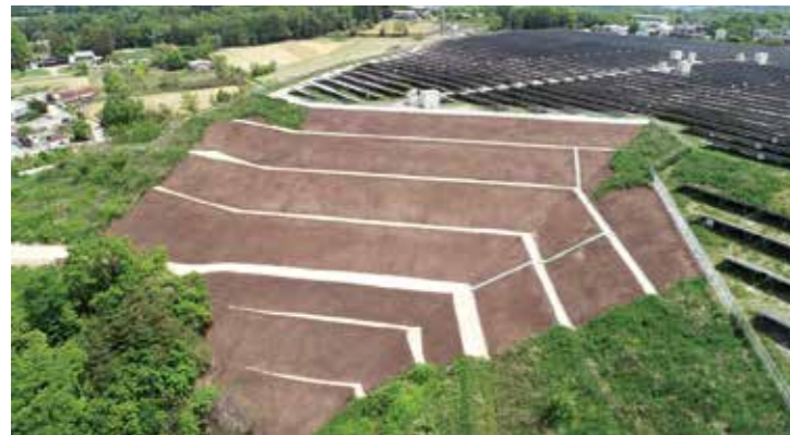
法面整備工事（兵庫県三田市）
