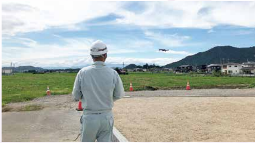
一人で作業できるドローン測量の導入で業務が効率化した。
