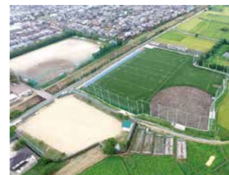
高等学校グラウンド整備工事（人工芝）
