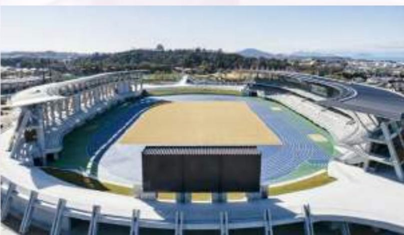
彦根総合スポーツ公園の中に建設された「平和堂HATOスタジアム」
