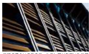
独特の風合いのあるコルテン鋼材を用いた外壁
