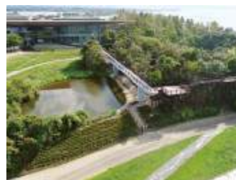
〈施工例〉橋梁下部工事・滋賀県発注
