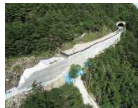
〈施工例〉道路改良工事・国交省発注
