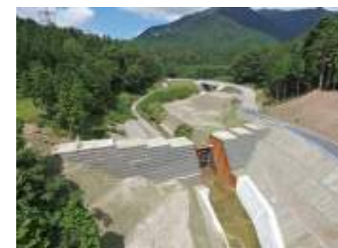
〈施工例〉砂防ダム工事・滋賀県発注
