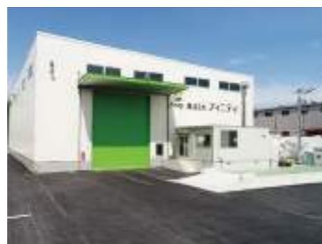
〈施工例〉工場建築工事・民間発注
