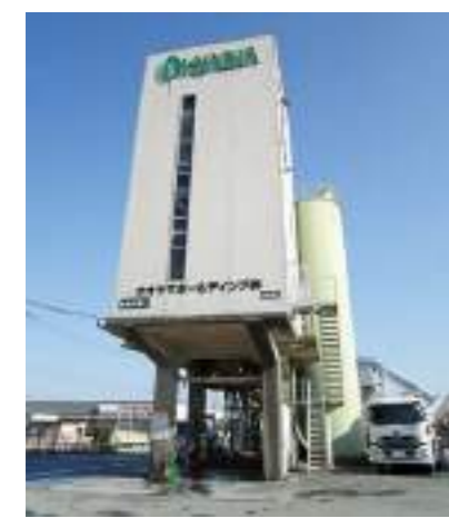
生コンプラント
