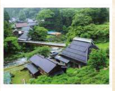
「新緑の頃」 小林 正治〔滋賀県〕 〈滋賀県東近江市〉
