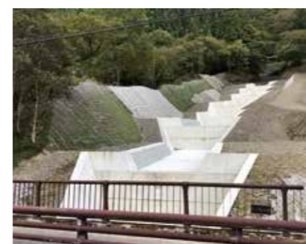
〈施工例〉 引ノ尻谷単独砂防工事
