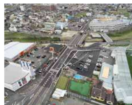
〈施行例〉 真野川広域河川改修工事
