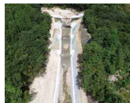
〈施行例〉 滝川補助通常砂防工事
