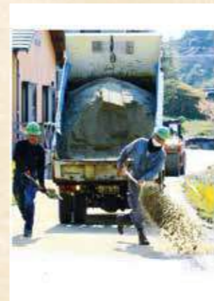
「舗装工事」乗松 賢二 [愛媛県]
