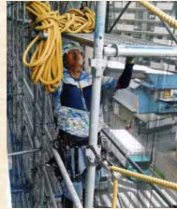
「足場組立」木村 菜津子 [滋賀県]
