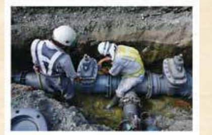
「水道管布設工事」高木 志津夫 [福島県]
