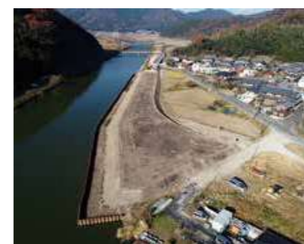
〈施工例〉 伊庭円山線補助道路整備工事
