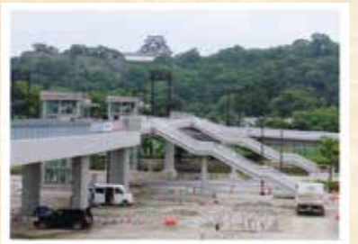
「お城へ続く歩道橋」 奥居 由紀夫〔滋賀県〕 〈滋賀県彦根市〉
