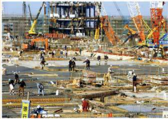
建設業労働災害防止協会滋賀県支部長賞 「プロの仕事場」河本 泉 [熊本県]
