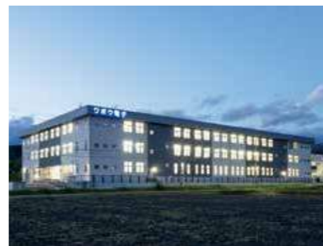
〈施工例〉ワボウ電子株式会社 浅井工場
