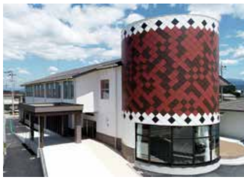
〈施工例〉愛荘町立山川原地域総合センター
