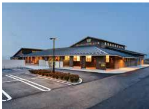
〈施工例〉京進のこどもえん HOPPA近江八幡
