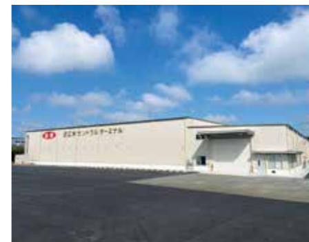
〈施工例〉JA全農近江米セントラルターミナル
