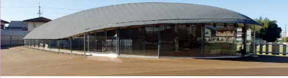
長径約37.5m、短径約14.9mの楕円状の外観が特徴的な遺構展示施設
