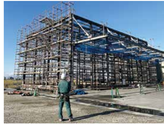
建設工事現場
